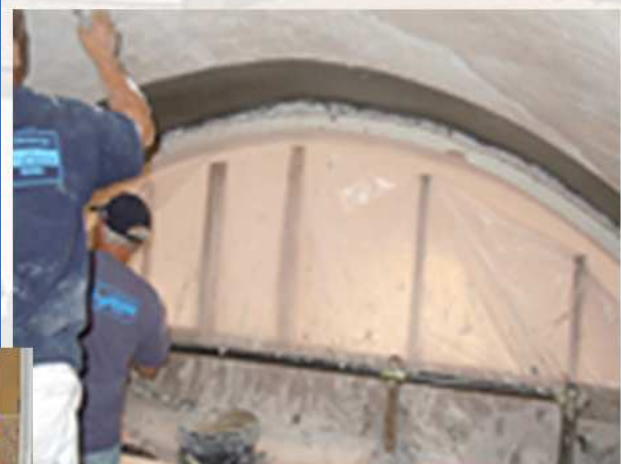
PRESIDENZA DELLA REPUBBLICA – Rifacimento di parte degli intonaci e della colletta, nonché tinteggiatura previo sgombrò dei materiali inerti presenti all'interno della Galleria di collegamento tra il Cortile d'Onore e il Viale della Lungamanica.
