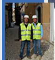
Puntellamento Via Roma Tecnici Impresa
